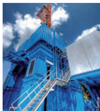
Seit Jänner wird in Ried gebohrt
